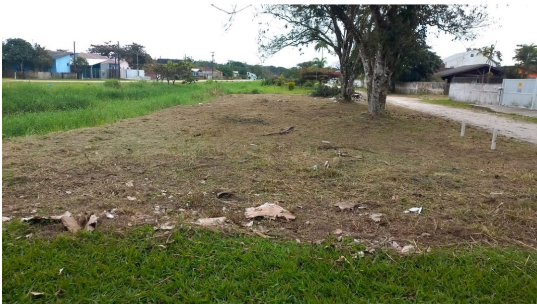
Figura 2 - Roçada de área adjacente ao canal
